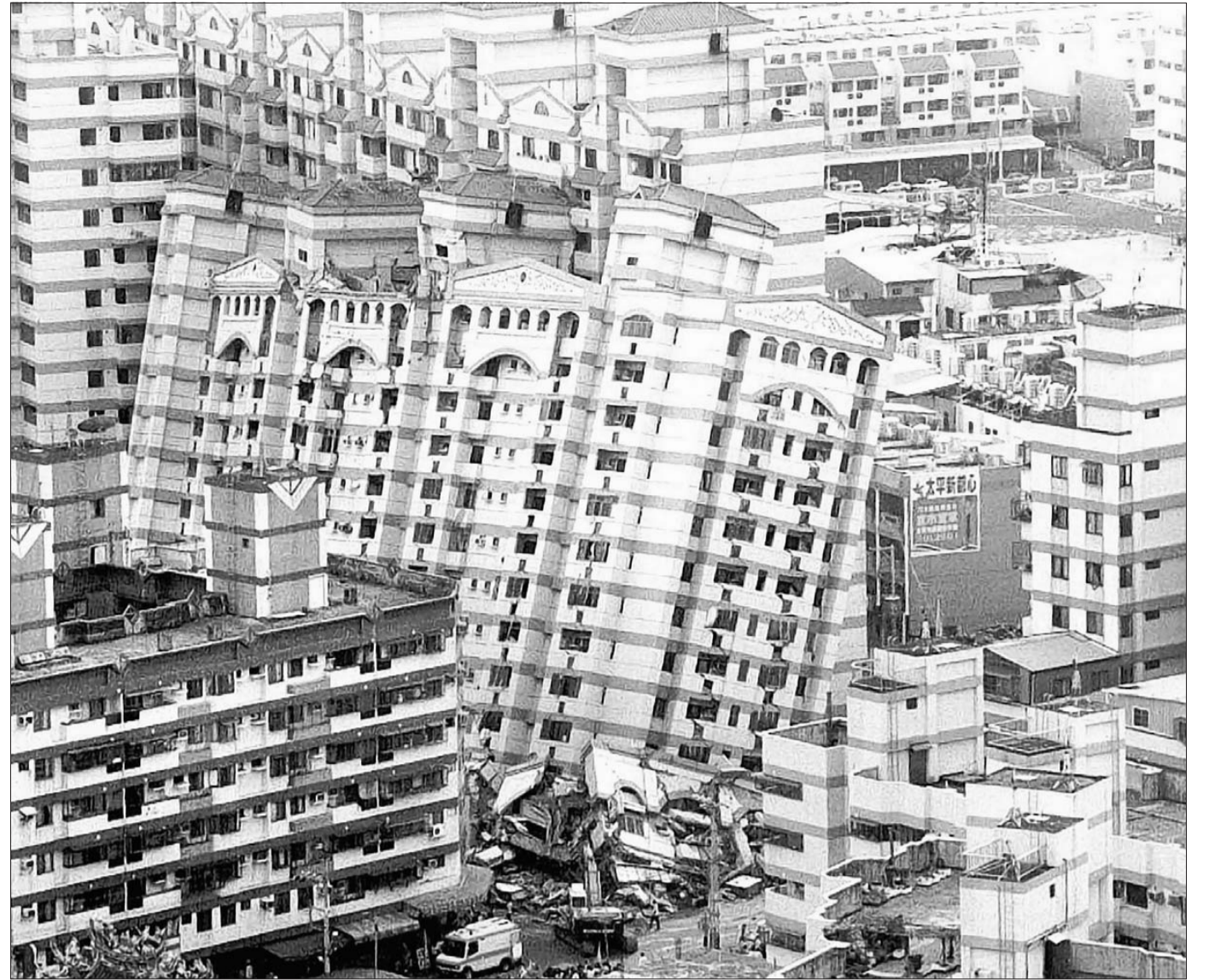
Umgestürzte Wohnblöcke nach dem schweren Beben der Stärke 8,1 vor sechs Jahren in Taiwan.
